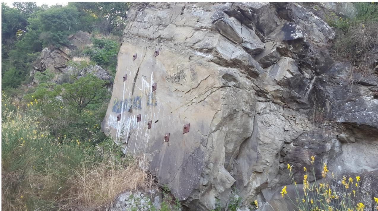
Fig. 3.4. Esempio di chiodatura realizzata su tutti gli affioramenti in fregio alla viabilità
