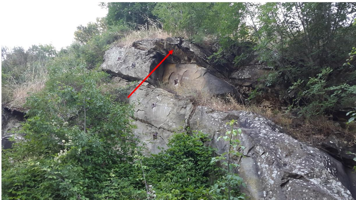
Fig. 3.7. Ulteriore situazione di potenziale dissesto localizzato. Si notino le chiodature che garantiscono la stabilità dell'affioramento.
