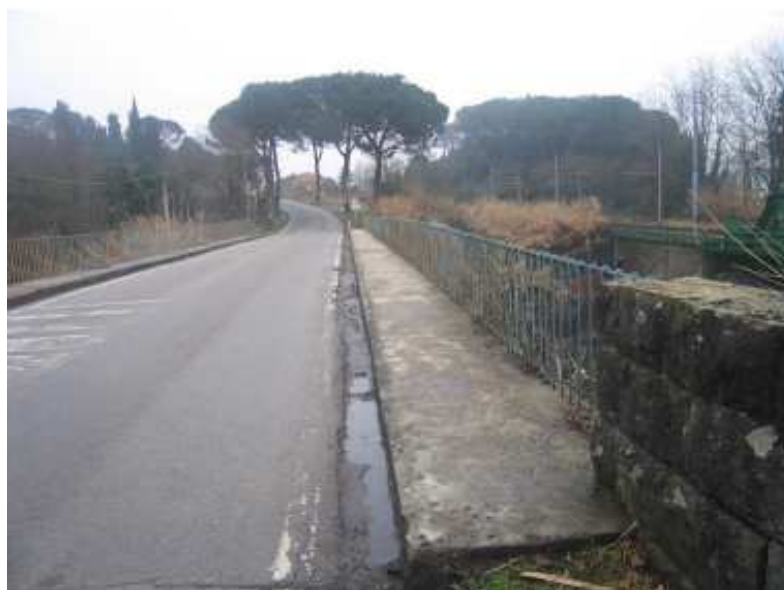
Figura 9 - Il ponte sul Torrente Ombrone, tratto di interruzione pista
