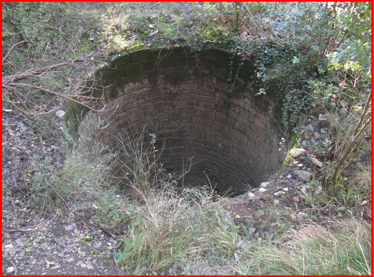
*La camera di combustione della fornace delle Ginestre*
