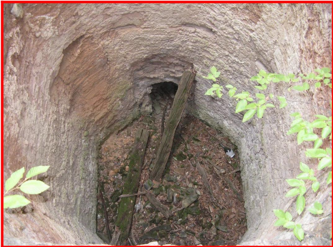
*Camera di combustione della fornace in località Poggio Agnelli (San Casciano Val di Pesa - FI)*
