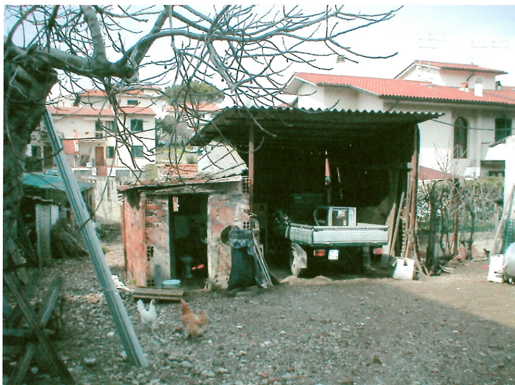
FOTO N°7 VISTA DEGLI IMMOBILI
