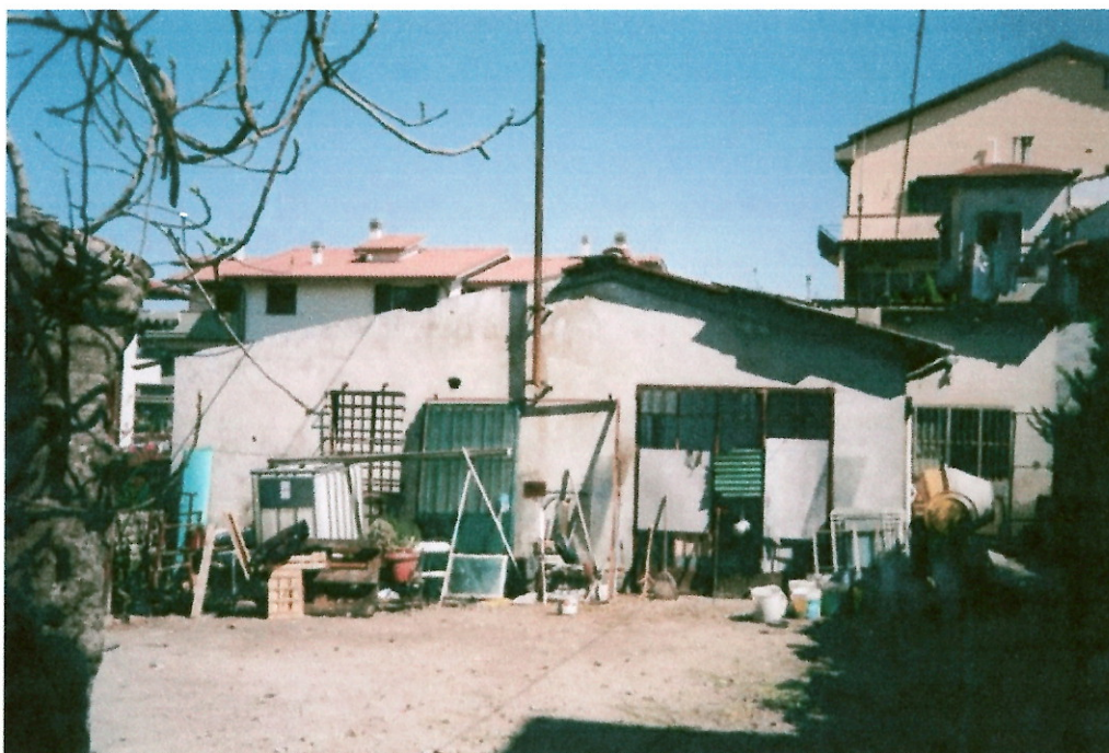
FOTO N°5 VISTA DEGLI IMMOBILI
