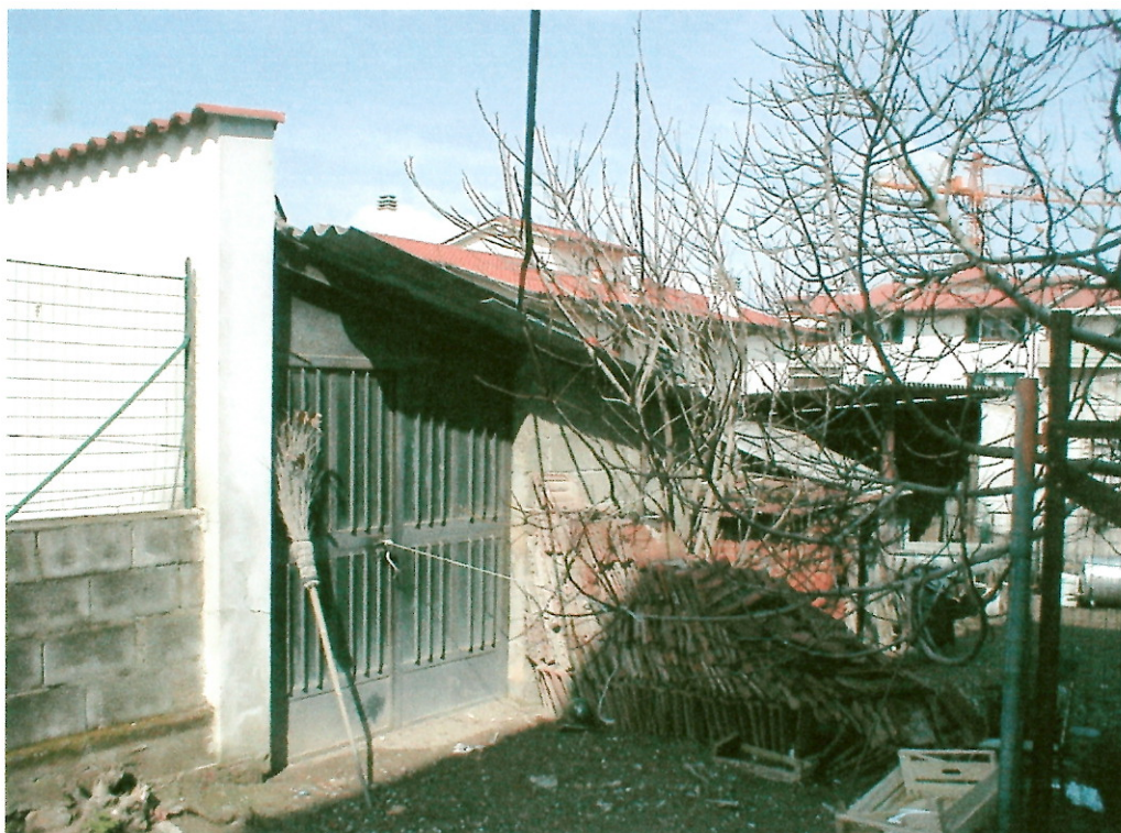
FOTO N°6 VISTA DEGLI IMMOBILI
