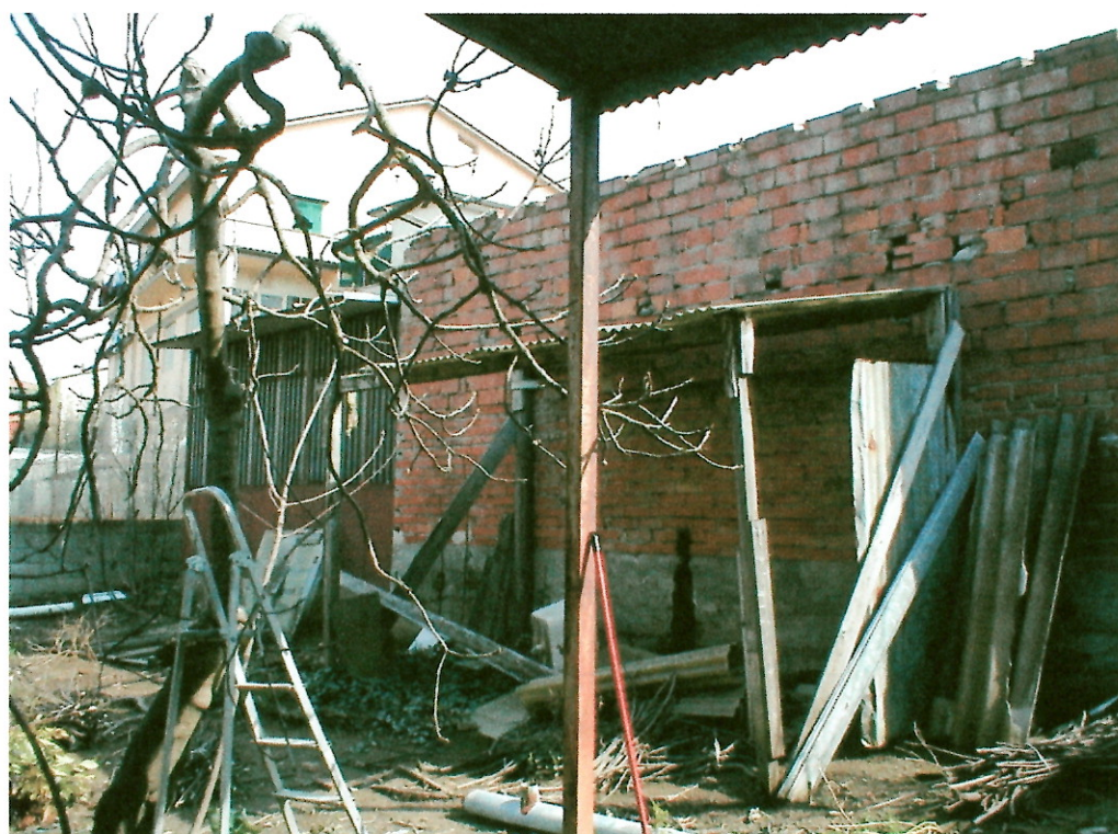
FOTO N°8 VISTA DEGLI IMMOBILI
